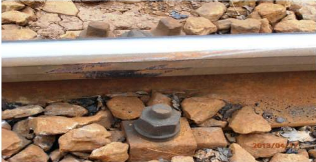
Foto 1. Locul escaladării șinei de către roata din stânga a primei osii de la vagon
