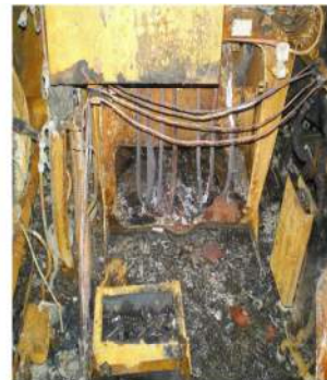
Fig. 3 Bloc S3 cabluri
